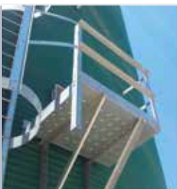
PLATEFORME DE REPOS
