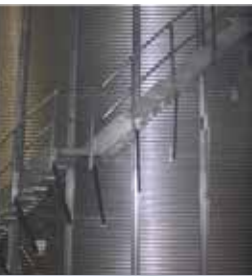
ESCALADA EM ESPIRAL Com distribuição em espiral ao redor do silo.
