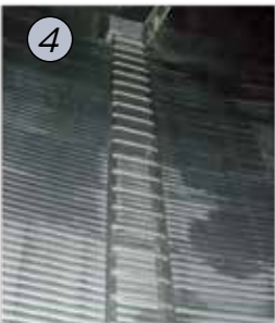
ESCALADA EM ZIGZAG Torre de estrutura metálica modular e galvanizada para facilitar o acesso à parte superior da instalação.
