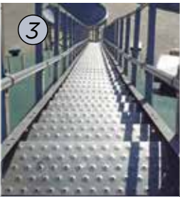
3 ESCALADA DE TELHADO Acesso fácil e seguro, com corrimão no telhajo.
