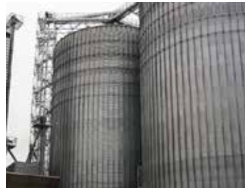
Facilita o acesso a torre de elevadores.
