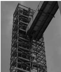
ESCALADA EM ZIGZAG Torre de estrutura metálica modular e galvanizada para facilitar o acesso à parte superior da instalação.
