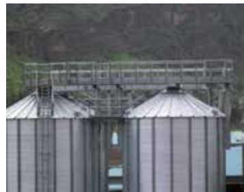
Ermöglicht den Zugriff auf die Inspektionsluke.
