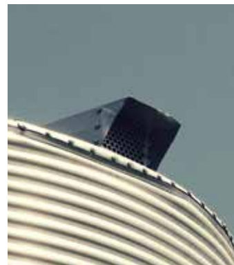
AÉRATION DANS LE TOIT
